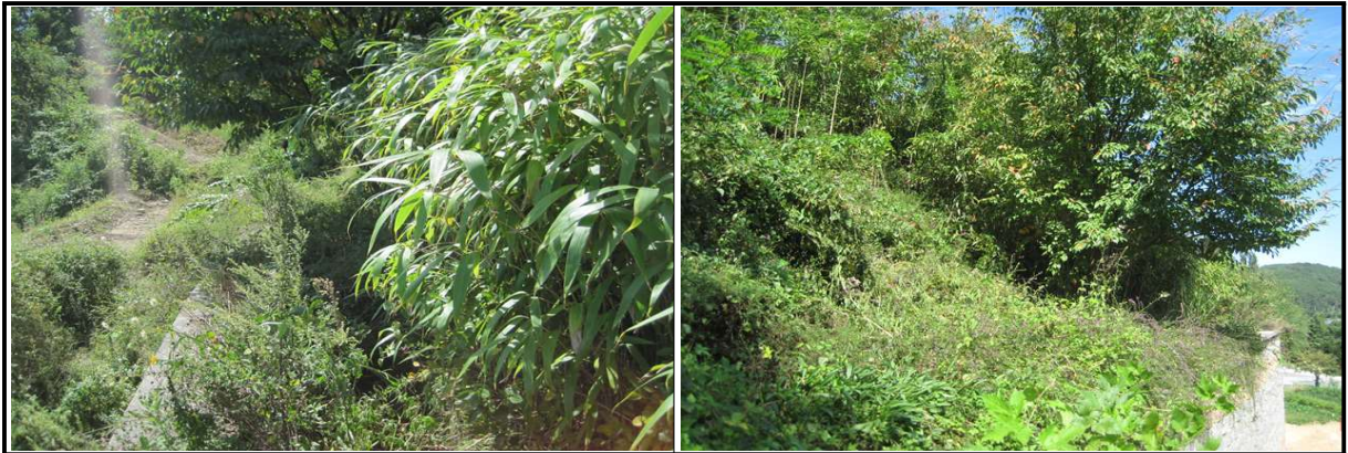
【그림 12.3.2】 주변영향인자 전경(보강토옹벽)
